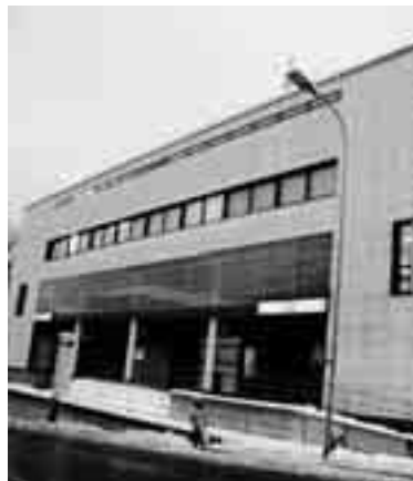
Ecco dove sorgerà la nuova centrale.
